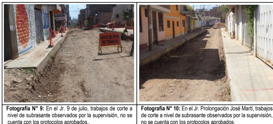
Fotografía N° 9: En el Jr. 9 de julio, trabajos de corte a nivel de subrasante observados por la supervisión, no se cuenta con los protocolos aprobados..
