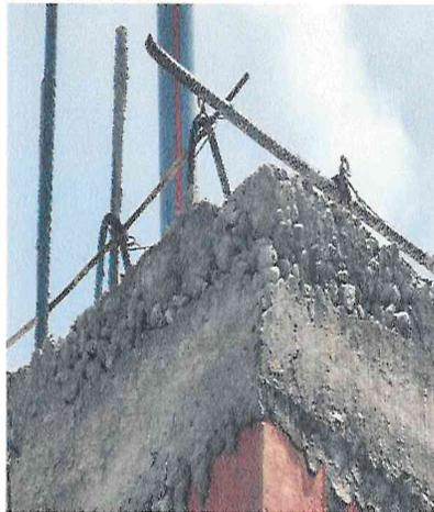
Vista de la presencia de canto rodado en las cangrejas expuestas en las vigas superiores de los módulos de SS.HH.
