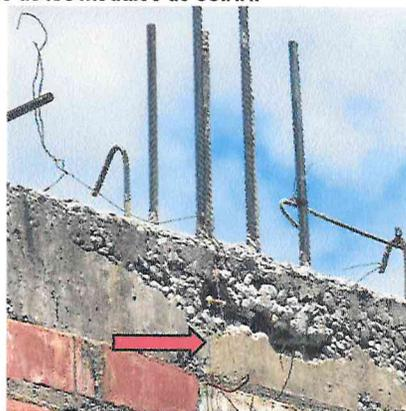
Vista de los aceros expuestos por no tener recubrimiento a causa de cangrejas en vigas.
