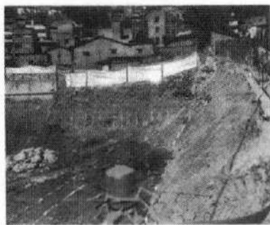
TRAZOS DE CALZADURAS EN ZONA POSTERIOR DE OBRA.
