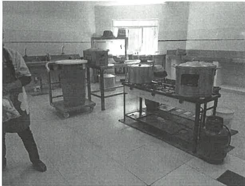
Fuente: Vista fotográfica del Área de Cocina, no se cuenta con rejillas de desagüe ni sumideros, día 3 de julio de 2023
