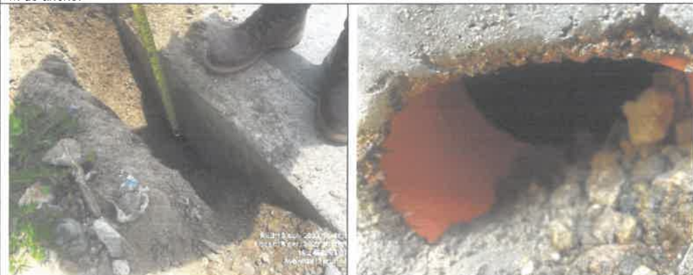
Descripción: Se identificó una tubería que se encuentra a 0,27 m por debajo de la superficie del canal donde se advierte la presencia de una tubería de 8" aproximadamente Fuente: "Acta de inspección física n.° 001-2023-OCI/VC-2434352" de 13 de octubre de 2023.
