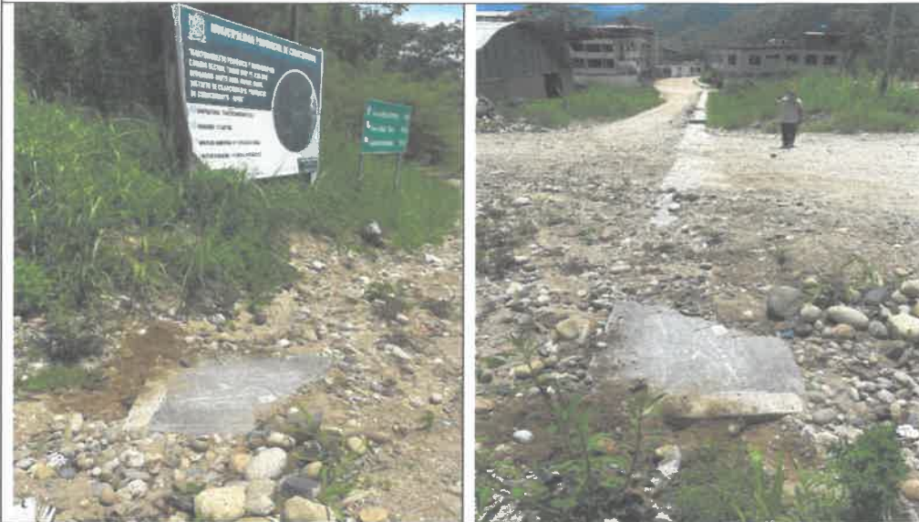
Descripción: Inicio del canal pluvial de concreto, ubicado en la intersección de la Av. Circunvalación y a Av. Ricardo Palma.
