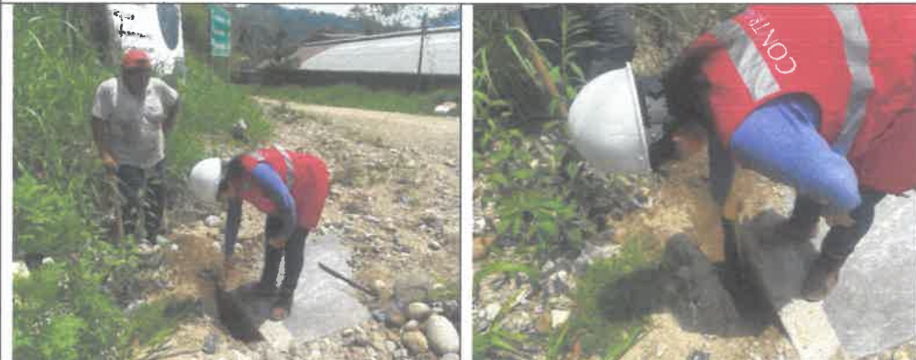
Descripción: En el ingreso del canal pluvial (1 etapa) se construyó un muro de concreto de 0,15 m de espesor y 1,12 m de ancho.
