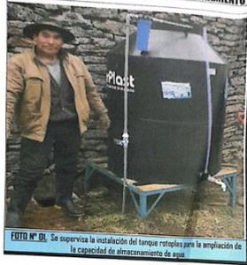
**FOTO N° 01.** Se supervisa la instalación del tanque rotoplas para la ampliación de la capacidad de almacenamiento de agua.
