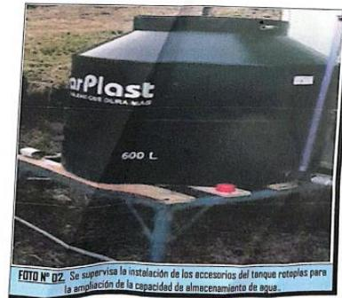
FOTO N° 02. Se supervisa la instalación de los accesorios del tanque rotoplast para la ampliación de la capacidad de almacenamiento de agua.
