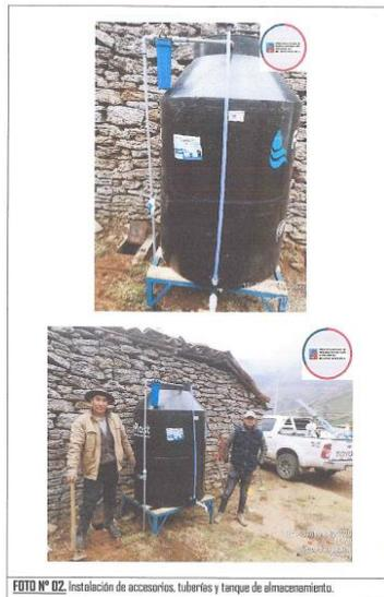
**FOTO N° 02.** Instalación de accesorios, tuberías y tanque de almacenamiento.
