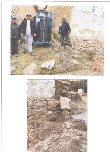
FOTO N° 01. Verificación de punto de instalación y coordinación con pobladores y autoridades. NO se encontró la presencia de agua en la vivienda y tubería rota.
