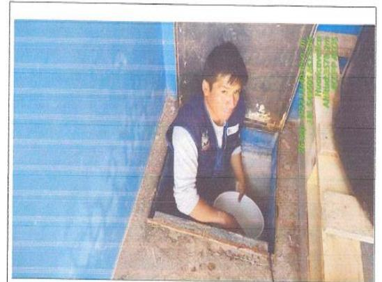
FOTO N° 01. Se evidencia al personal del ATM realizando la medición del caudal al ingreso al reservorio.
