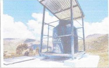
Fotografía N° 2: Caseta de sistema de cloración con estructura de metálica y techo de calamina, cuenta con protecciones laterales y techo totalmente deteriorado. Necesita la reparación.
