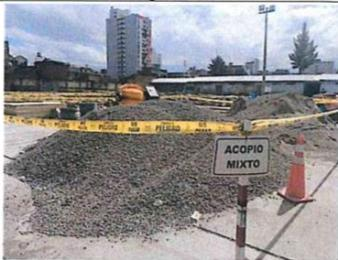
**Descripción:** Se constata área denominado "acopio mixto", en su interior se aprecia arena gruesa y arena fina, distinguidos uno del otro, y están sobre la losa de concreto antiguo por demoler. El residente de obra manifiesta que los agregados constatados son para los trabajos de obras provisionales.
